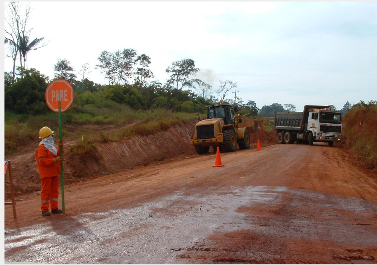
Fig. 2 (arriba): Construcción de carreteras a lo largo de la carretera interoceánica (Salisbury, 2007).
